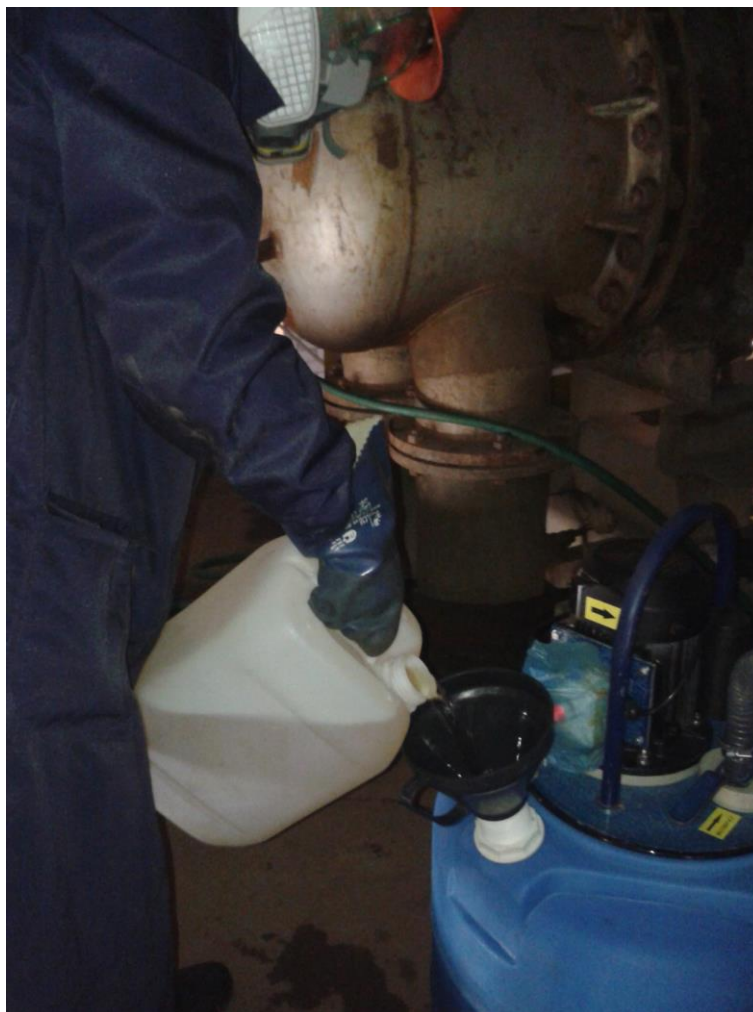
Рисунок 4 Подогреватель с подключённым химически стойким циркуляционным насосом
